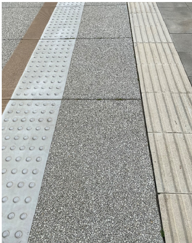
Fot. 5. Przykład fakturowego oznaczenia typu A i B na peronie dworca kolejowego
