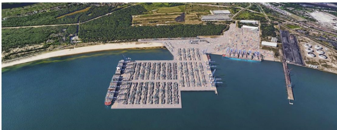
Rysunek 1 Baltic Hub po rozbudowie o terminal T3 Źródło: https://baltichub.com/inwestycje/projekt-t3
