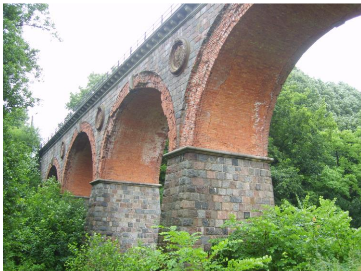
Fot. 1. Most kolejowy w Bytowie (Kszuby) nad rzeką Borują z końca XIX w. 6 murowanych z cegieł przęsł o sklepieniach kolistych, wspartych na granitowych podporach. Na filarach płaskorzeźby z piaskowca przedstawiające herby Rzeszy, Prus, Pomorza, Bytowa i niemieckich kolei (fot. U. Myga-Piątek). Obiekt był nominowany w ogólnopolskim konkursie „Zabytek Zadbane 2021” w kategorii "Rewaloryzacja przestrzeni kulturowej i krajobrazu". Kapituła przyznała wyróżnienie Gminie Bytów za udane działania konserwatorskie i za zagospodarowanie otoczenia, które wyeksponowały zabytek oraz uczyniły okolicę mostu jedną z ważniejszych przestrzeni rekreacyjnych miasta.
