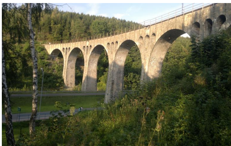
Fot. 2. Wiadukt w Lewinie Kłodzkim nad doliną Bystrej i drogą krajową nr 8. niezelektryfikowanej trasy linii kolejowej nr 309 z Kłodzka do Kudowy-Zdroju wybudowany przez włoskich inżynierów w latach 1903-1905 (fot. U. Myga-Piątek). Po rewitalizacji (2013) linia kolejowa biegnie malowniczą trasą, w tym około pół kilometra pod masywem Grodzca, w okolicy Kulina Kłodzkiego.
